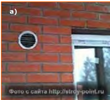
Рис. 3. Вид стенового приточного клапана: а) со стороны улицы, б) с внутренней стороны помещения
