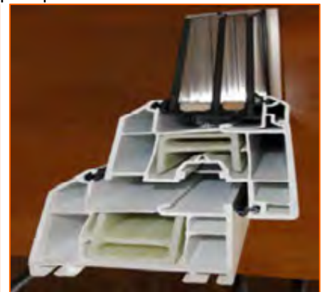
Рис. 3. Применение в коробке и створке ПВХ-профиля вместо стальных усилителей стеклопластикового армирования
