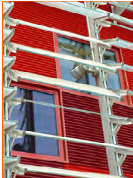
Рис. 5, 6. Здание «Торре Агбар» с регулируемыми стеклянными жалюзи на фасаде, г. Барселона, Испания
