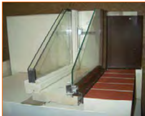
Рис. 10. Деревянные оконные блоки с наружной створкой из алюминия.
