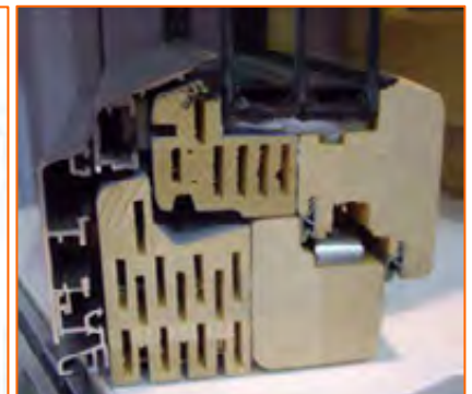
Рис. 8. Пропил деревянного бруса в коробке и створке с созданием дополнительных воздушных камер
